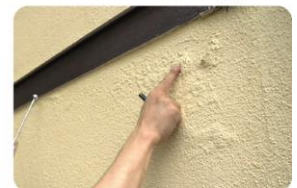
外壁の浮きやハガレをチェック。
