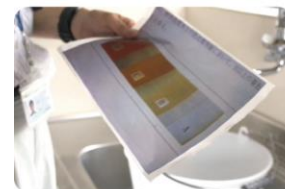
水回りの錆、作動状況をチェック。
