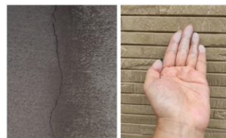
壁のひび割れ 手に白い粉がつく
